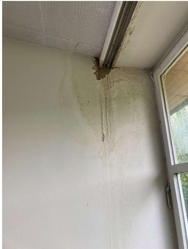
Foto 22: Verschalung Dachüberstand – Schaden durch Regenwasser
